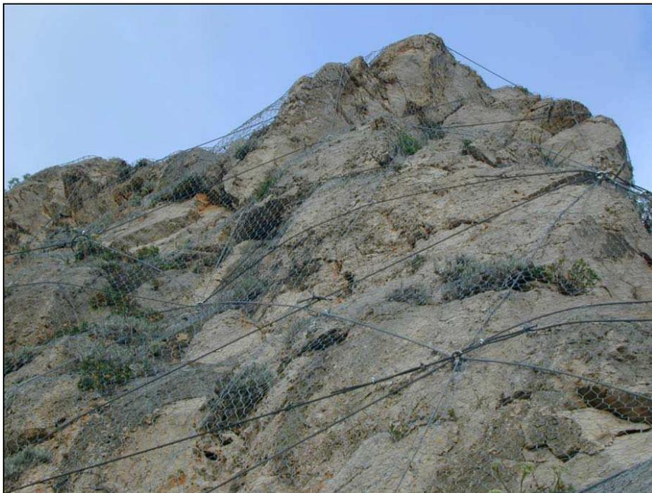
Rivestimento di una parete rocciosa fratturata, con reti metalliche per la protezione della sede stradale interessata da fenomeni di caduta massi.
