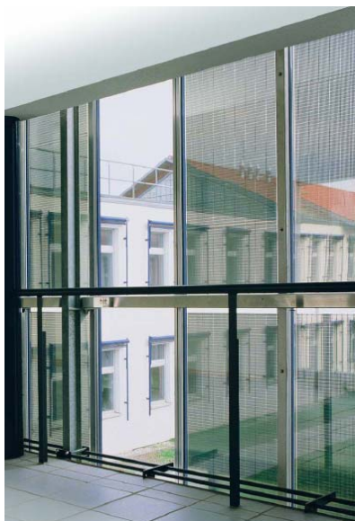
Figura 4.2.6 – Applicazione in edilizia di pannelli a film sottile su supporto semi-trasparente
